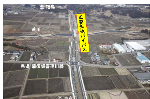
新荒川橋付近（福島方面を望む）
