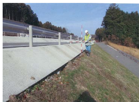
<法面の点検状況>
