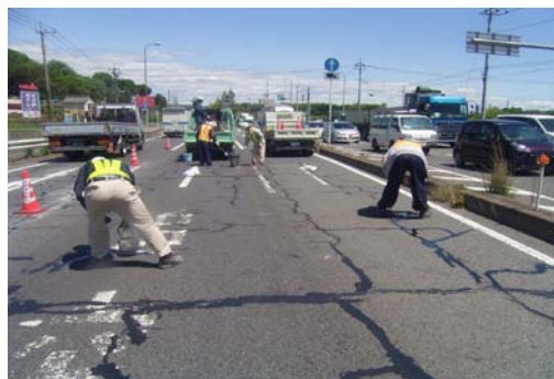
〈シール材注入〉
