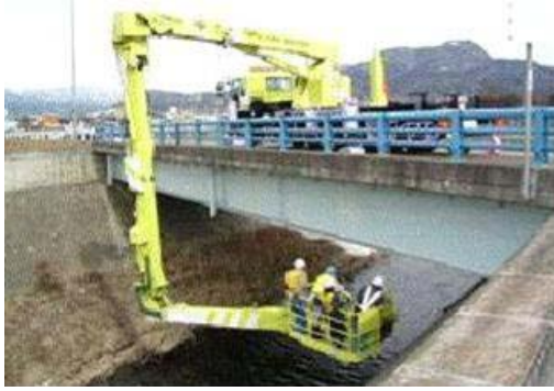
< 橋梁点検車による点検 >
