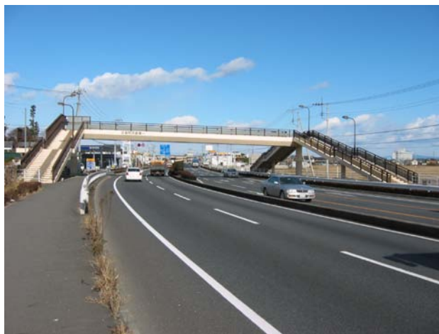
〈国道4号 川岸第2歩道橋〉
