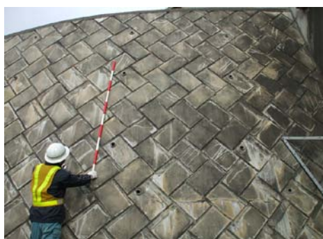
<擁壁の点検状況>
