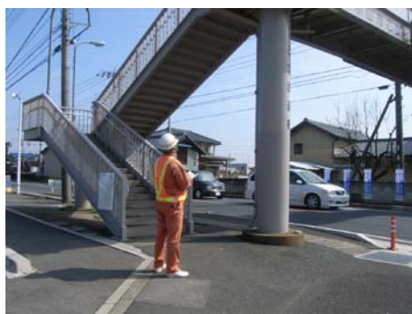
〈定期巡回による歩道橋の点検〉
