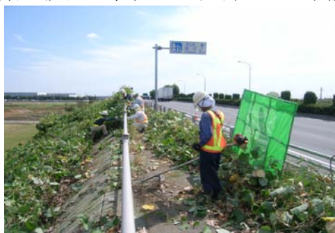
〈除草（歩道、法面部）〉
