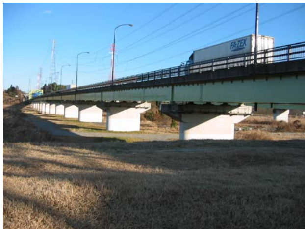
〈国道4号鬼怒川橋〉
