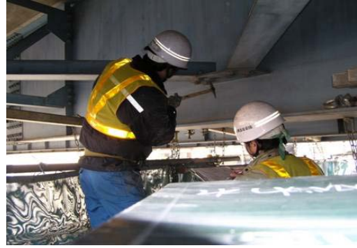
< 橋梁下部点検状況 >
