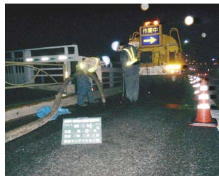
〈排水構造物清掃〉
