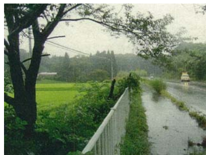
〈異常時巡回状況〉
