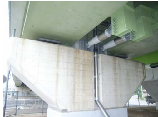
< 変位制限装置設置 >
