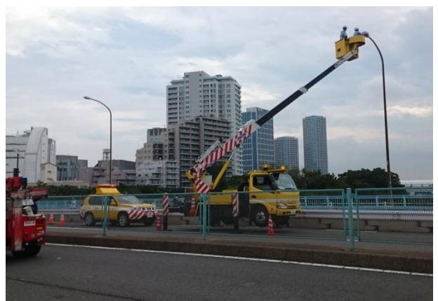
高所作業車による点検訓練
