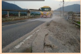
散水車作業状況
