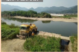
散水車給水状況
