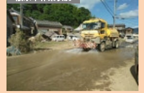
散水車作業状況
