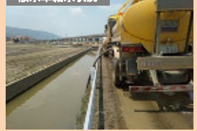
散水車給水状況
