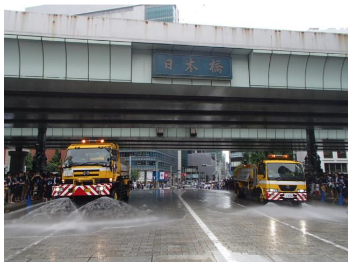
橋洗いの仕上げは散水車(2台)による洗浄です 今年も再生水で実施しました
