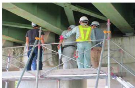
足場を利用した点検事例
