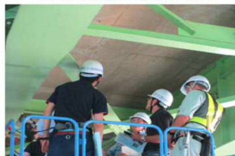
高所作業車による点検事例
