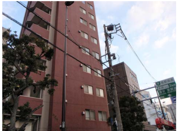
電線復旧 (6時36分)
