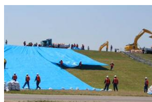
水防団による訓練 （裏シート張り工）
