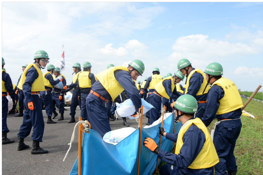
改良積土のう工法
