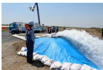
排水ポンプ車による 緊急排水活動
