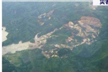
荒砥沢ダム貯水池 (宮城県栗原市)
