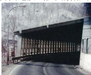
〈スノーシェッド〉 (国道17号 みなかみ町永井)
