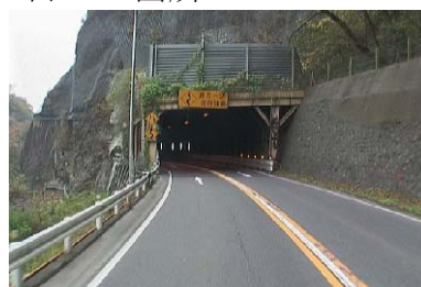
〈ロックシェッド〉 (国道17号 渋川市上白井)
