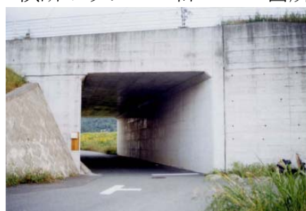
〈板鼻道路ボックス〉 (国道18号 安中市板鼻)
