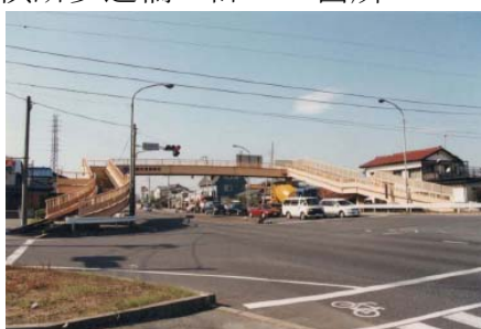
〈倉賀野歩道橋〉 (国道17号 高崎市倉賀野町)
