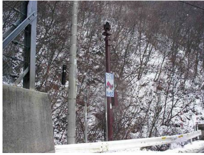
〈新治 CCTV カメラ〉 (国道17号 みなかみ町永井)
