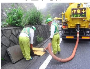
〈側溝清掃(機械)〉
