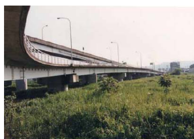
〈君が代橋〉 (国道18号 烏川渡河部)
