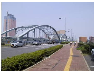
〈群馬大橋〉 (国道17号 利根川渡河部)
