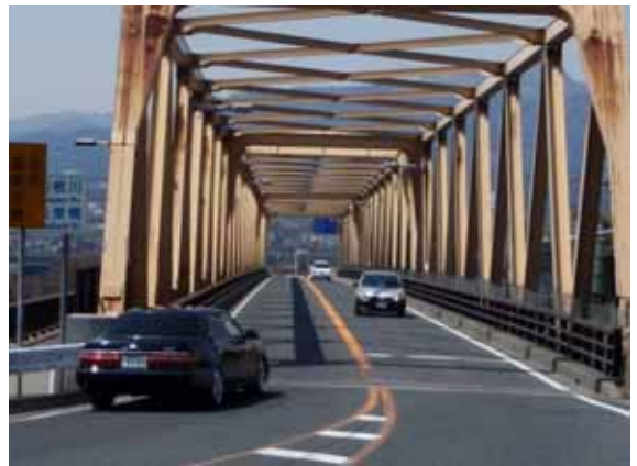
開通後の坂東橋 H22.4.18撮影
