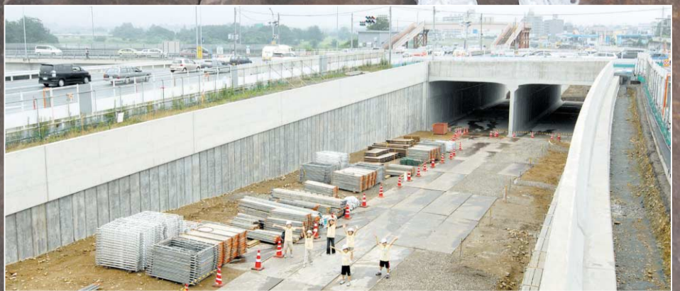
こくどう たかまつりったい 国道17号高松立体の工事現場を見学する子ども記者
