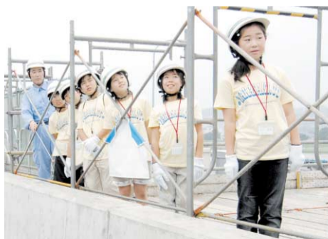
足場の上から工事全体のようすを見渡す
