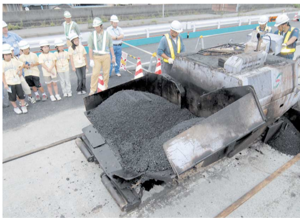
目の前でアスファルト道路ができあがっていく
