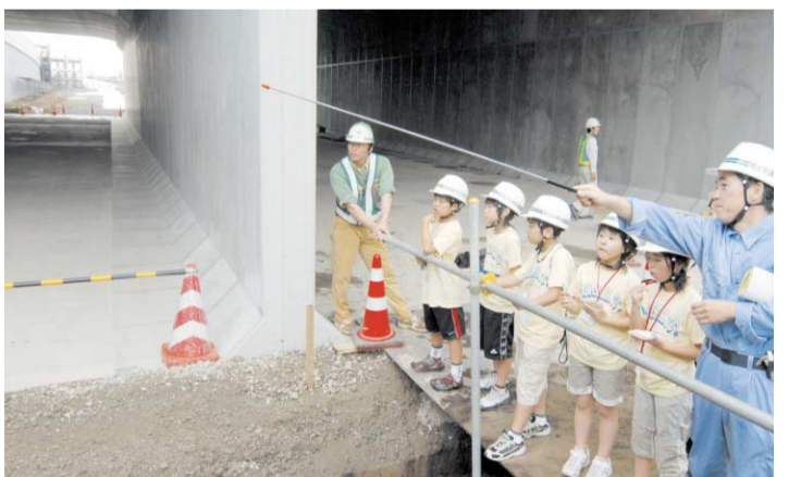
大きなトンネルにびっくり! 完成したらここを車が走るんだ
