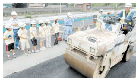
コンバインドローラーで踏み固める
