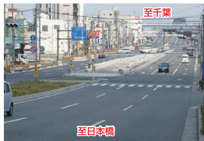
江戸川区小松川3丁目付近(6車線拡幅済)
