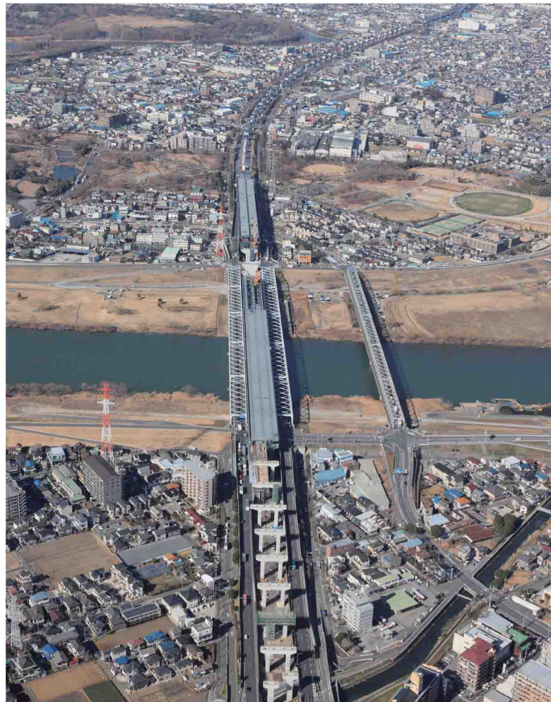
▲松戸市小山付近(江戸川架橋)
