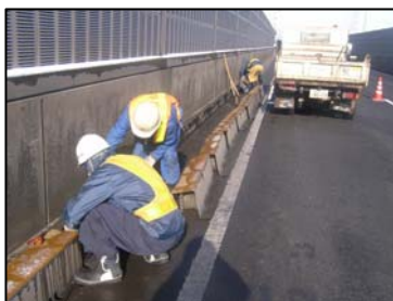
〈側溝清掃（機械）〉
