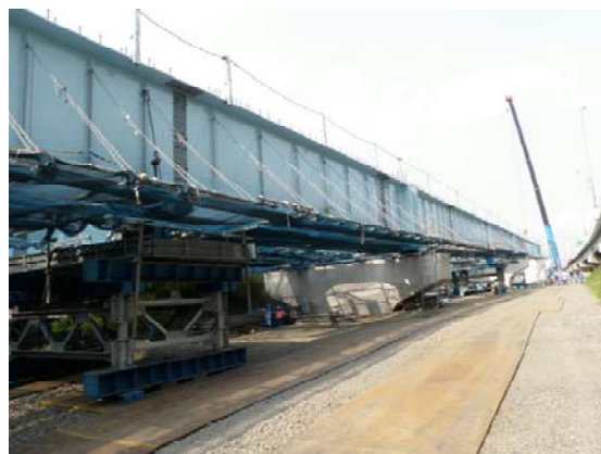
架設の終了した上部工
