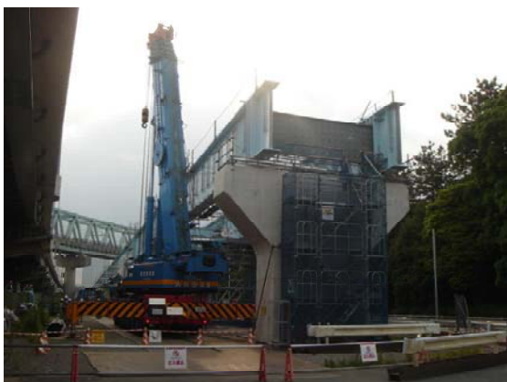
160tクレーンによる架設
