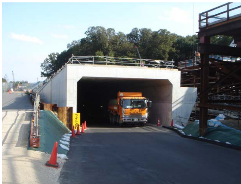
小塚山トンネル工事
