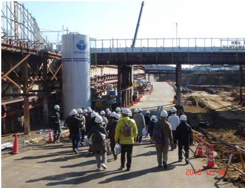
掘削工事状況
