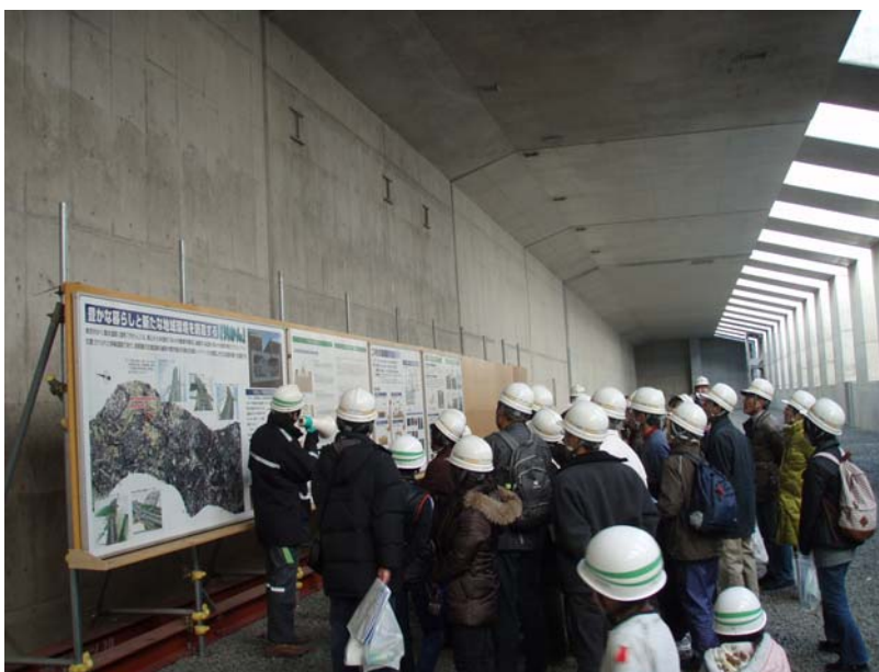
国分地区掘削部試験工事
