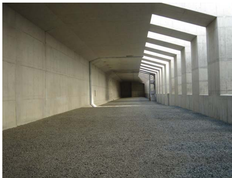
国分地区掘割部試験工事
