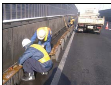
〈側溝清掃（機械）〉
