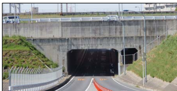
〈国道298号 上矢切隧道 (国道6号交差部)〉
