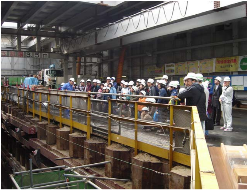
小塚山トンネル工事
