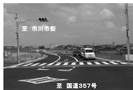
写真 C: 開通区間の状況写真【高谷3交差点】 平成 21 年 8 月 12 日(水) 12 時頃撮影
