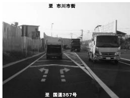
開通区間の状況写真【田尻5北2交差点】 平成21年9月26日(土) 16時頃撮影
