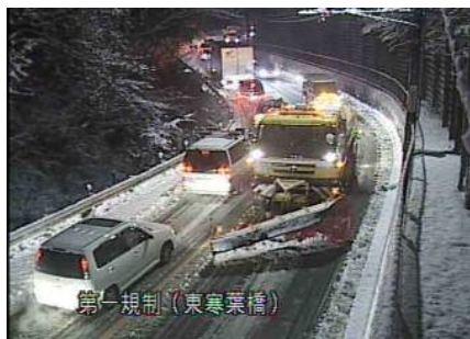
除雪作業状況
