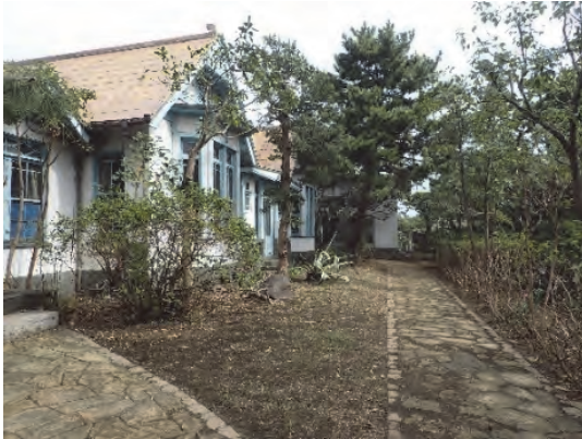
写真 4 洋室棟南側外観 (2018 年 10 月撮影)
