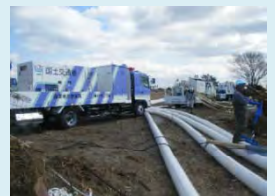
名取川周辺での排水作業状況
