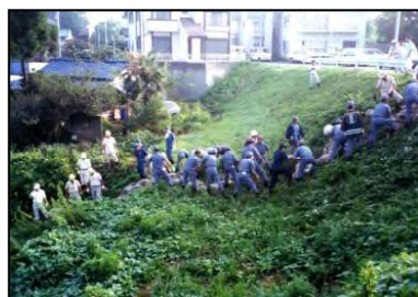
水防団による月の輪工法実施状況
