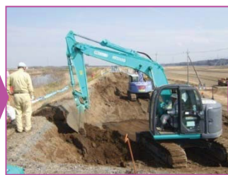
検討の後、必要とされた箇所は、直ちに災害復旧工事に着手
