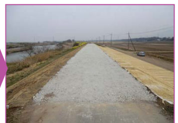
災害復旧工事が完了
