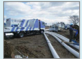
名取川周辺での排水作業状況
