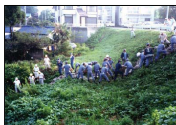
水防団による月の輪工法実施状況
