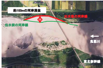
出水により河岸が削られた(鬼怒川東北新幹線下流) (平成13年9月洪水)
