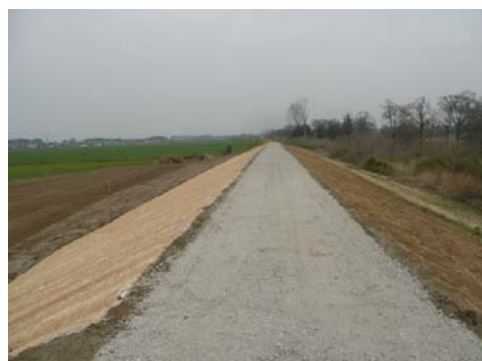
復旧後(平成23年4月7日撮影)
