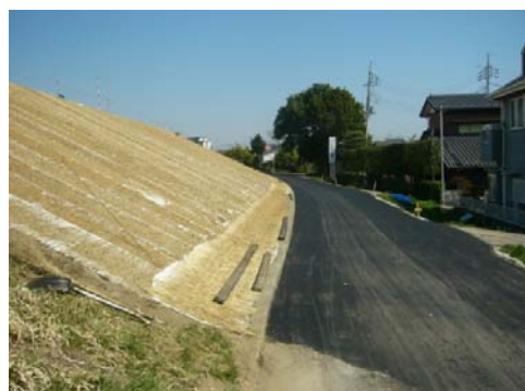
復旧後(平成23年4月6日撮影)
