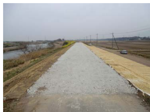
復旧後(平成23年4月7日撮影)
