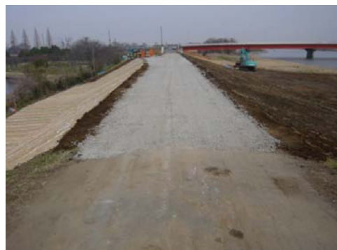
復旧後(平成23年4月2日撮影)
