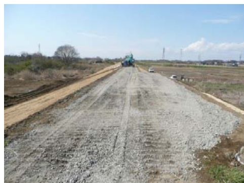
復旧後(平成23年3月31日撮影)
