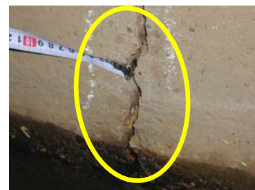
側壁のクラック (L=120cm, W=1.0cm) ※クラックに伴う漏水による堤体土砂の吸出 11/16
