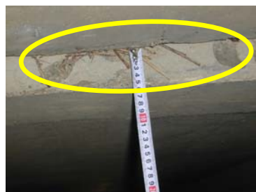
函体の段差 (W=5.0cm) ※段差に伴う漏水による堤体土砂の吸出
