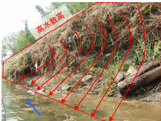
河岸洗掘箇所(右岸46.0k付近) 筑西市下川島地先
