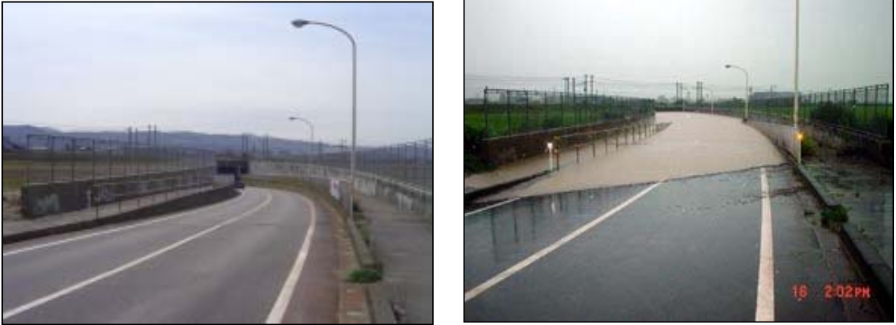
図 6 平成 16 年 7 月 新潟県三条市アンダーパスの浸水状況 (左 平常時、右 浸水時) (出典：国土交通省 国土地理院ホームページ)
