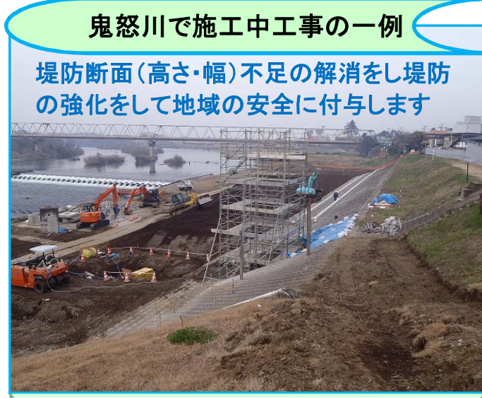
鬼怒川で施工中工事の一例 堤防断面(高さ・幅)不足の解消をし堤防の強化をして地域の安全に付与します 本町(上)築堤工事 (鎌庭出張所管内:常総市本町地先)
