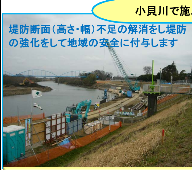
小貝川で施工中工事の一例 堤防断面(高さ・幅)不足の解消をし堤防の強化をして地域の安全に付与します 杉下築堤護岸工事 (藤代出張所管内:つくばみらい市杉下地先)
