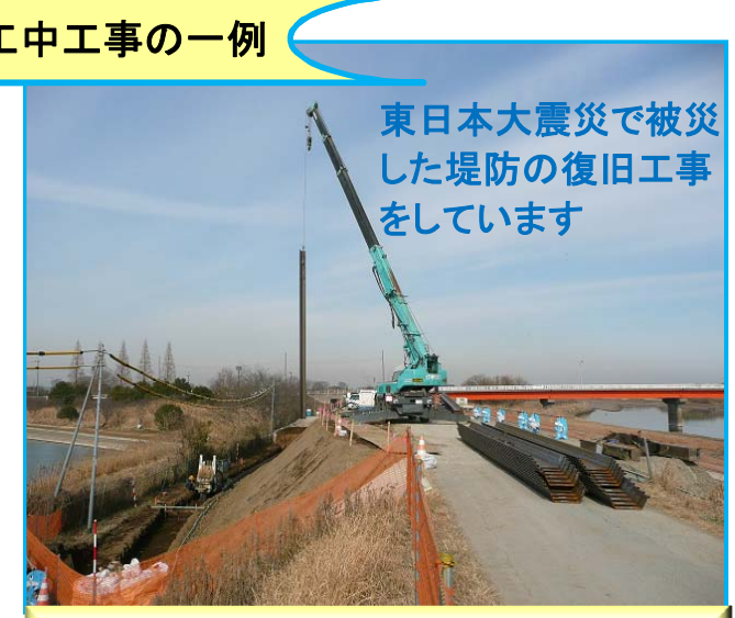
小貝川で施工中工事の一例 堤防断面(高さ・幅)不足の解消をし堤防の強化をして地域の安全に付与します 東日本大震災で被災した堤防の復旧工事 をしています 小貝川堤防(上蛇地先外)災害復旧工事 (水海道出張所管内:常総市上蛇地先)
