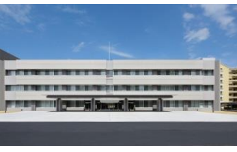
関東管区警察学校 本館・教場棟
