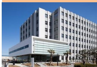
横須賀地方合同庁舎
