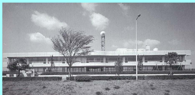
立川防災合同庁舎
