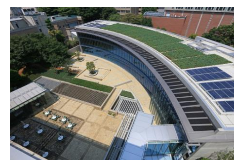
太陽光発電と屋上緑化
