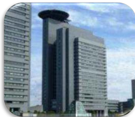
さいたま新都心合同庁舎 2号館
