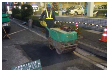
〈路面補修状況（パッチング）〉
