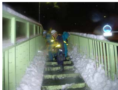
〈歩道橋除雪作業状況〉
