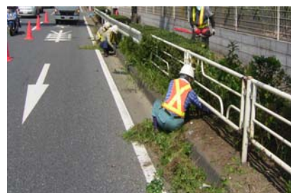
〈抜根除草状況（植樹帯）〉
