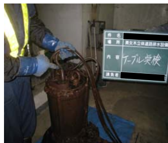
〈排水設備 定期点検状況〉
