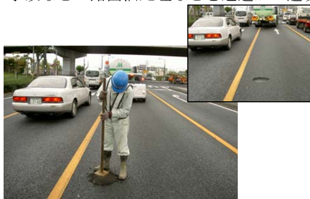
〈路面補修状況（ポットホール補修）〉
