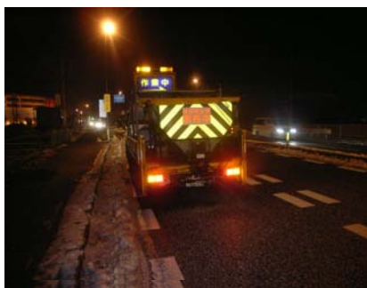
〈凍結防止剤散布状況〉
