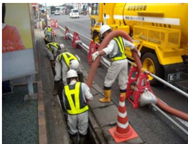
〈側溝清掃状況（機械）〉
