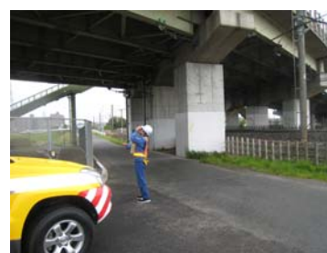
〈橋梁の点検状況〉
