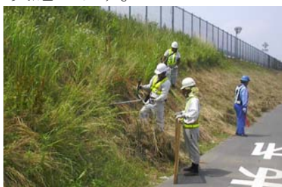
〈機械除草状況（法面）〉
