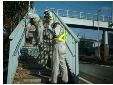
〈歩道橋の清掃状況（人力）〉
