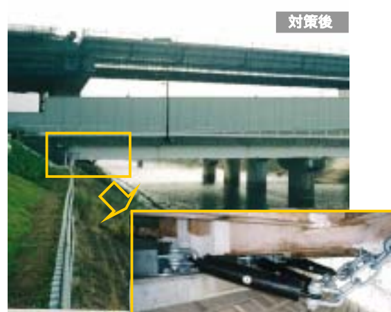
橋台補強(コンクリート増厚、地盤改良)と落橋防止装置の設置 (国道298号 三郷放水路側道橋)
