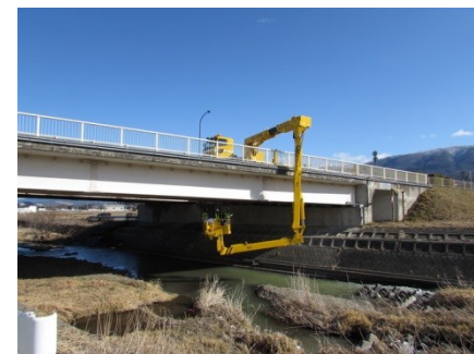
【橋梁点検車による点検状況】
