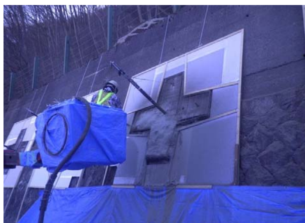
施工状況写真
