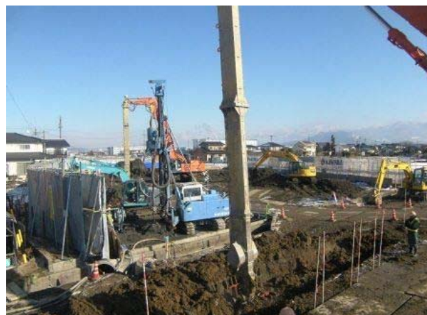
施工状況写真
