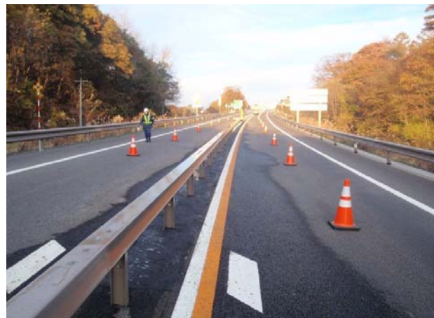
作業状況写真
