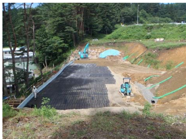
施工状況写真
