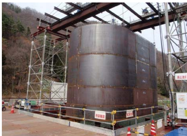
施工状況写真
