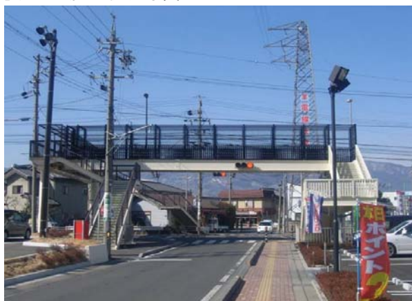
完成(いもじや歩道橋) 市道側より
