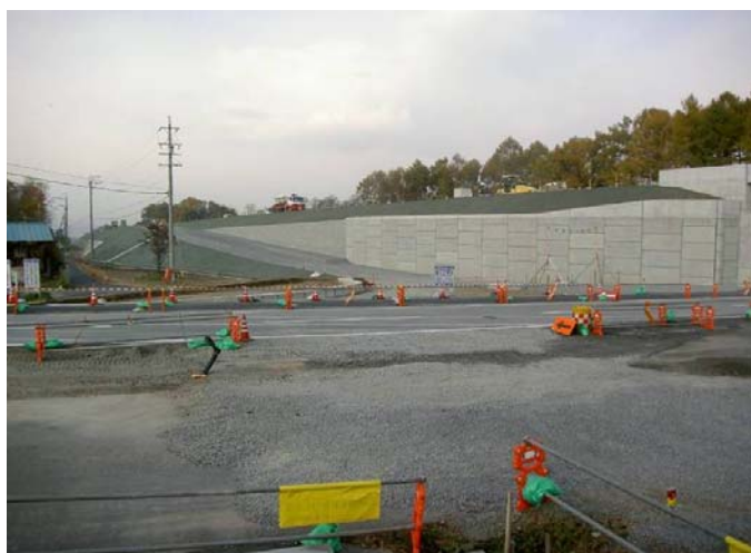
完成又は施工状況写真
