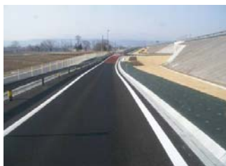
完成又は施工状況写真
