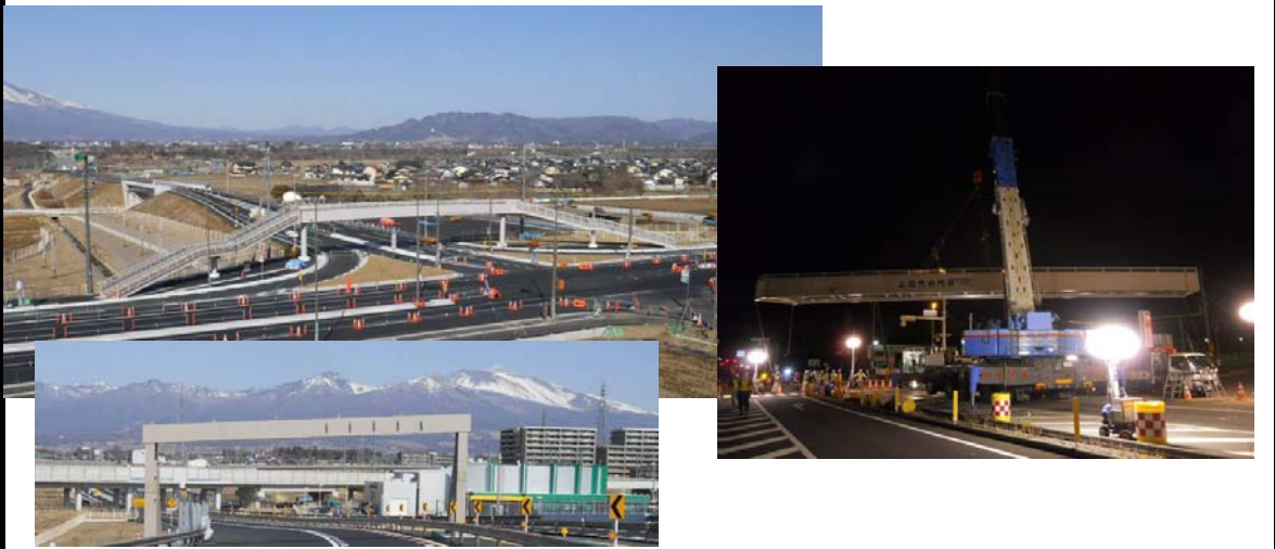
完成又は施工状況写真
