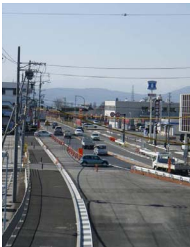
完成又は施工状況写真
