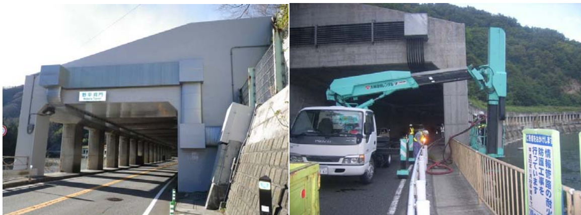
完成又は施工状況写真
