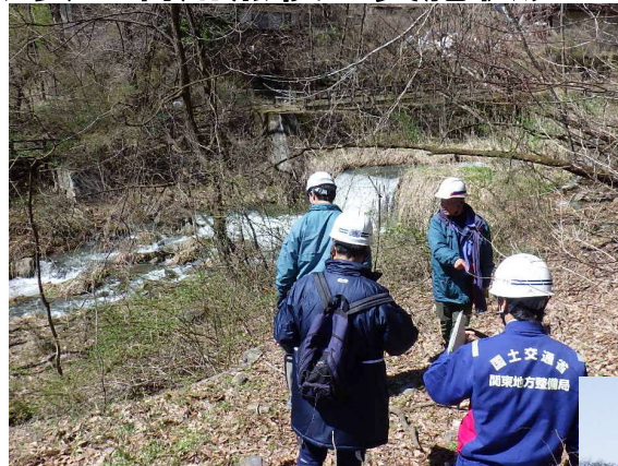
▲釜無川上流域の点検状況
