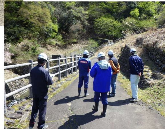
▲早川流域の点検状況
