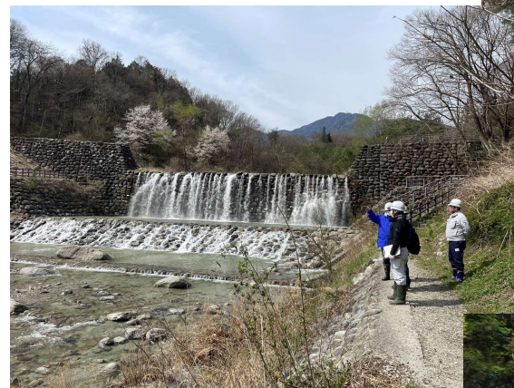
▲尾白川流域の点検状況
