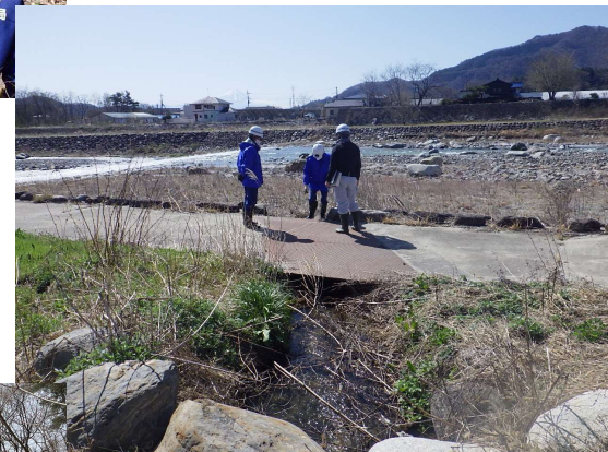
▲大武川流域の点検状況▲
