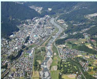
だいやがわ 大谷川床固工群
