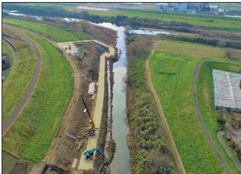
佐野市高橋町地区（旗川）における河道掘削・低水護岸工事
