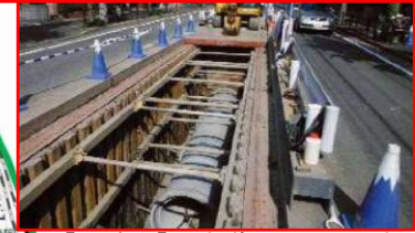
【川崎市】下水道における雨水排水施設の整備
