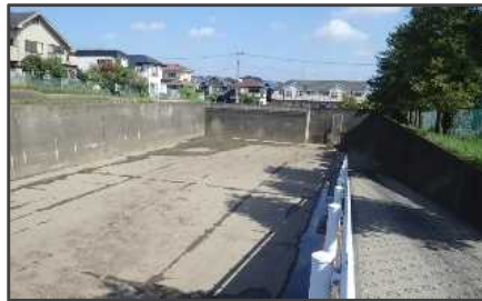
雨水貯留浸透施設の例
