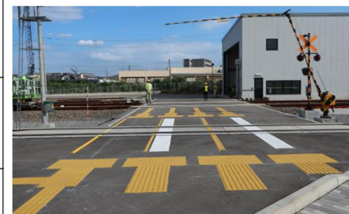
本実験の誘導表示等の敷設状況 4
