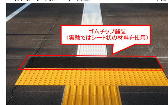
➤評価実験で実施したゴムチップ舗装
