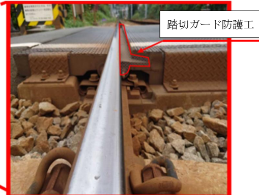
写真 2-7-34 踏切ガード防護工の設置事例
