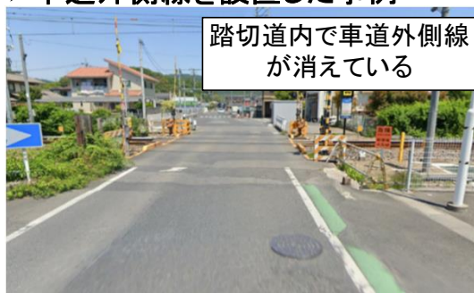
➤車道外側線を設置した事例
