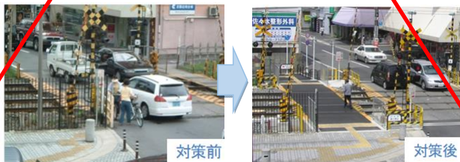
写真 2-1-26 踏切拡幅（歩道新設）の例
