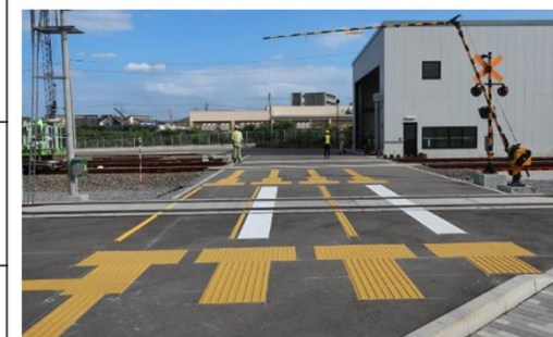
本実験の誘導表示等の敷設状況 4
