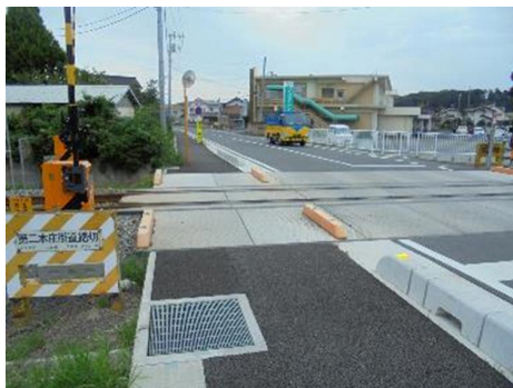
写真 2-7-31 ブロック等により分離している例
