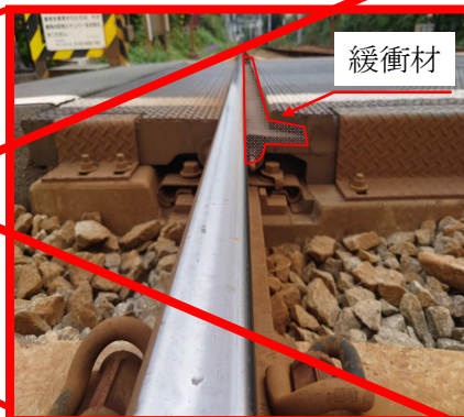
写真 2-1-33 緩衝材の設置事例
