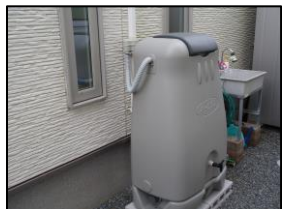
貯留槽の整備事例（富士市）
