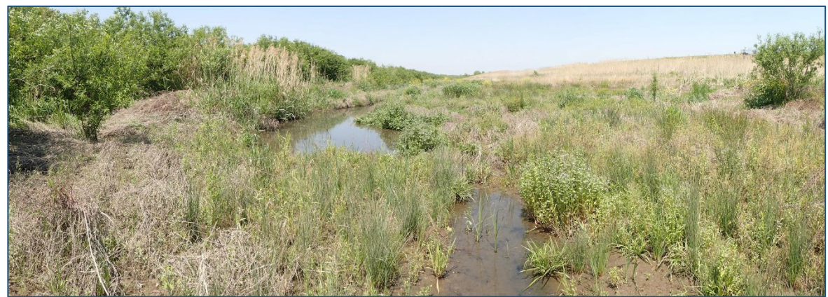
● 治水対策における多自然川づくり 生物の多様な生息・生育環境の創出 河道掘削(写真は平成30年度掘削箇所である江戸川左岸41k付近座生地区の掘削後3年目の様子)
