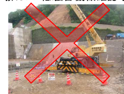
排ガス・低騒音機械確認写真
