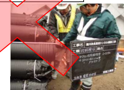
監督職員、現場技術員の臨場写真
