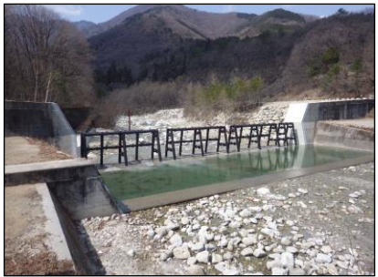
尾白川第三砂防堰堤
