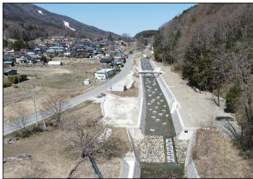
武智川下流第7床固(R4年度完成)
