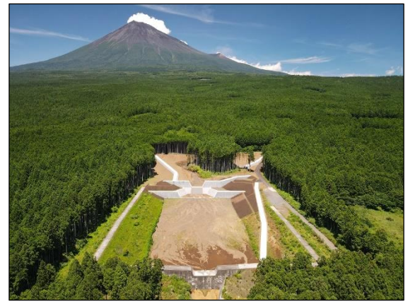
立堀沢遊砂地工 (R4年度完成)
