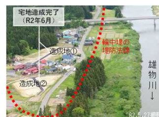
移転先宅地造成完了状況
