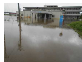
浸水時の状況 (喜多方市提供)
