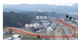
移転家屋の建設が進む状況
