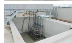
工場での浸水対策例 （株式会社佐賀鉄工所HPより）
