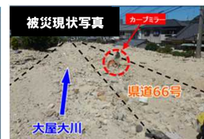
被災前イメージ 被災現況写真 平成30年7月豪雨により発生、流出した土砂が、県道等に2m以上堆積し、被害を拡大させた(広島県呉市天応西条地区)
