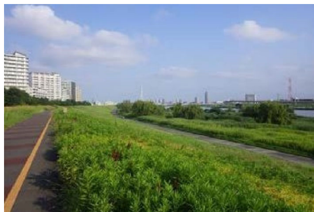
図 2-20 緩傾斜堤防の例
