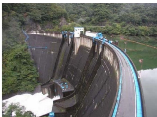
図 1-4 荒川上流部の二瀬ダム
