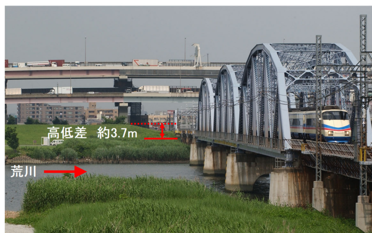
図 2-84 京成本線荒川橋梁付近の堤防の状況
