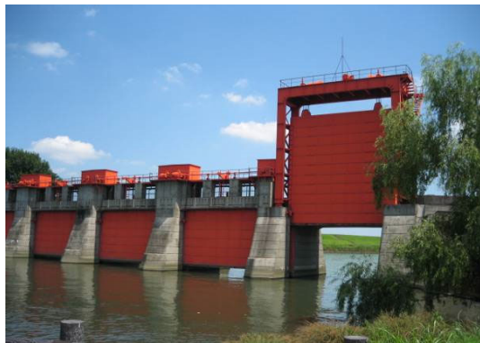
旧岩淵水門付近（北区）
