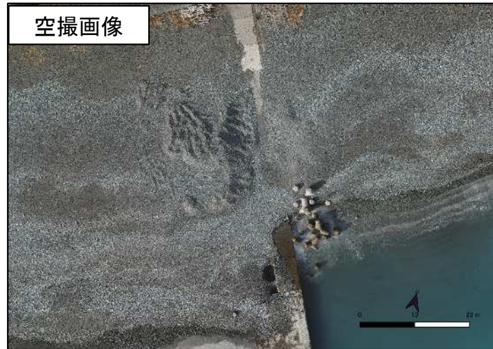
図-1 二宮漁港の突堤付近の空撮画像
