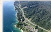
三陸沿岸道路（岩手県山田町）
